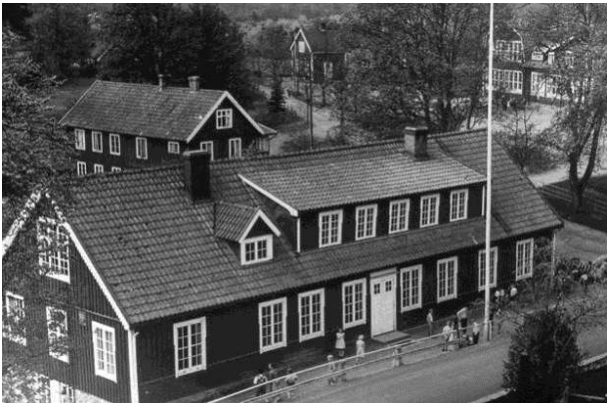
Kommunala Mellanskolan och fröken Klaras skola är två byggnader, som sedan länge är rivna och uppeldade.
